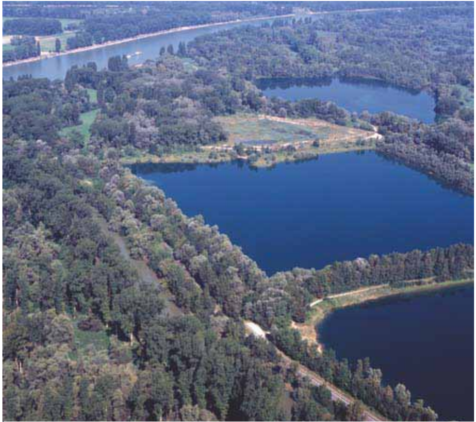
Die Rheinauen bei Oberhausen-Rheinhausen: Sie bilden wichtige Überflutungsflächen und sind damit zentral für den Hochwasserschutz.
