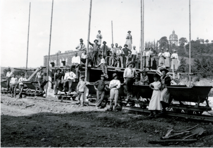
Italienische Arbeiter beim Bau des Bahnhofs Schöntal. 1901 wurde der Bahnhof eingeweiht – mit sichtlich stolzen Transalpini, die am Bau der Jagsttalbahn zahlreich beteiligt waren.
