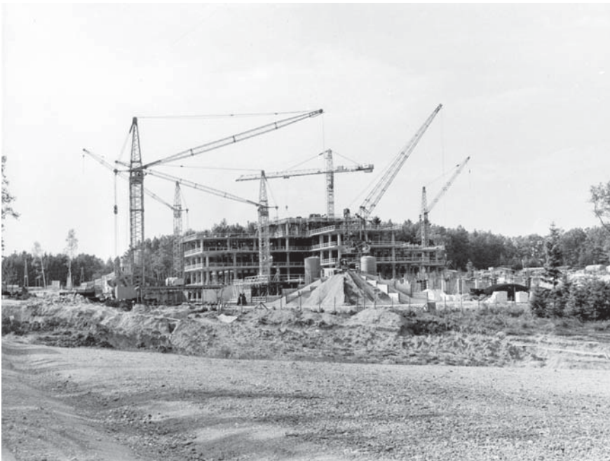
Bau der Universität Ulm im Juni 1970.
