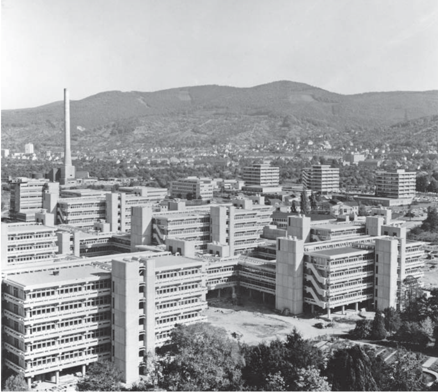
Expansion des Bildungswesens: Im Neuenheimer Feld in Heidelberg werden 1972 neue Institute der Universität gebaut.
