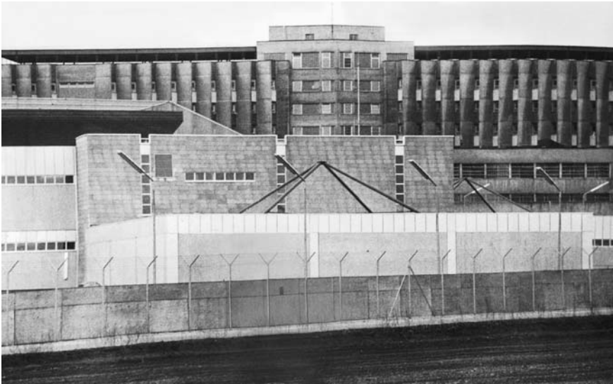
Der Komplex aus dem einstigen Reformgefängnis und dem neuerrichteten Mehrzweckgebäude erscheint wie ein Hochsicherheitstrakt. Diese Perspektive fanden die Pressefotographen 1975 auf einem Feldweg an der Ostseite des Geländes.
