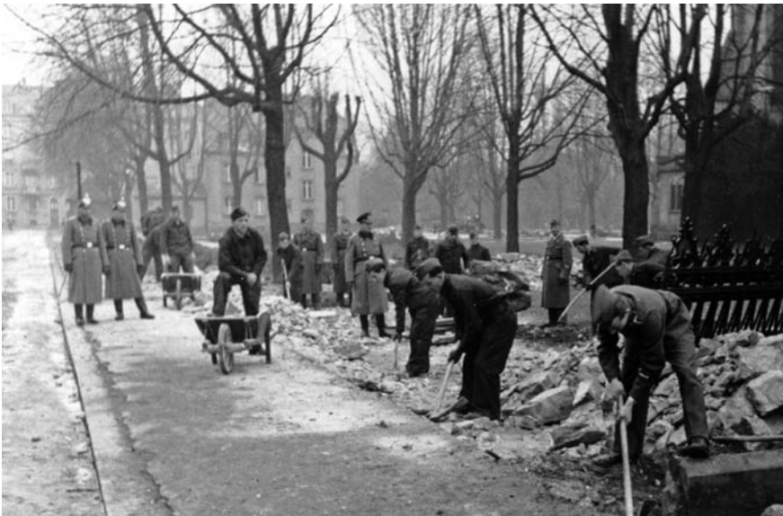
Kriegsgefangene werden in Freiburg bei Straßenbauarbeiten von Polizisten bewacht (Foto undatiert).
